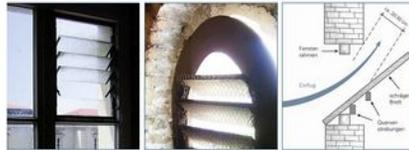
Abb. 17: Ein taubensicherer Zugang für Fledermäuse zum Dachboden des Schlosses Herrenchiemsee.
